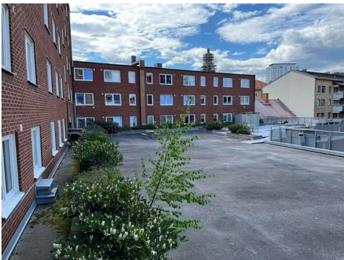
Foto, fasad (innergård)
