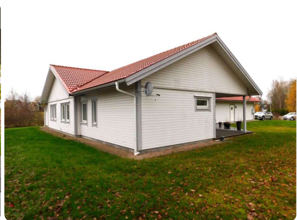
Byggnadens nordvästra hörn.
