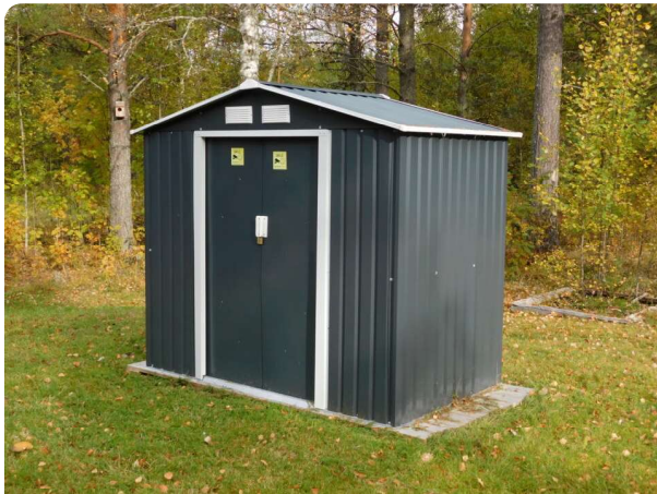
Övrig byggnad, okänt ändamål. Plåtfasad med plåttak.
