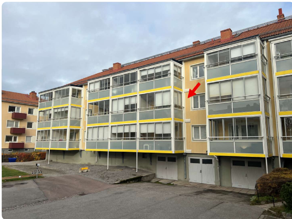
Flerbostadshus med beige fasad och inglasade balkonger, värderingsobjektet markerat
