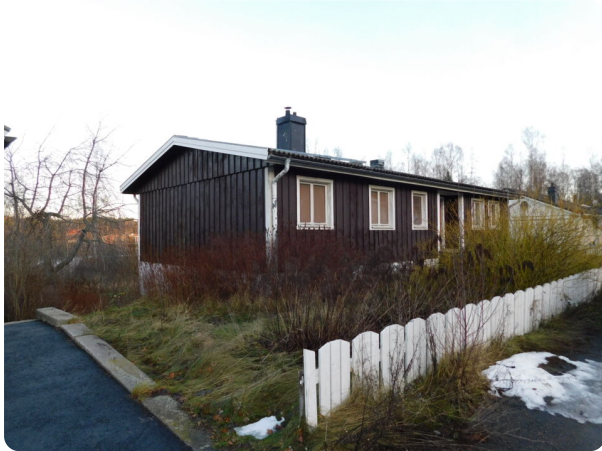
Huvudbyggnad, fasad mot anslutande väg.
