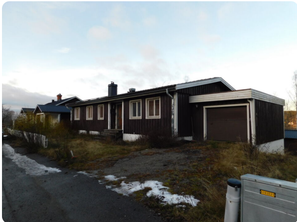
Huvudbyggnad, fasad mot anslutande väg.
