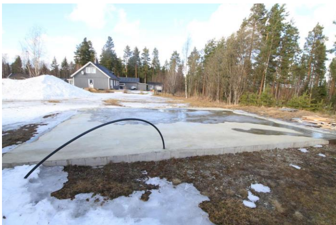
Foto, gjuten platta för planerat garage.
