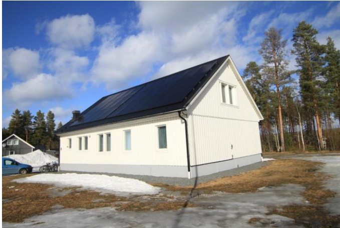
Foto, huvudbyggnad i 1½ plan vitmålad träpanel, svartplåttak med solpaneler.
