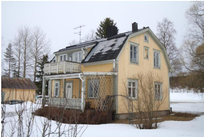
Foto, huvudbyggnad i 2 våningar, gulmålad träpanel med vita detaljer.
