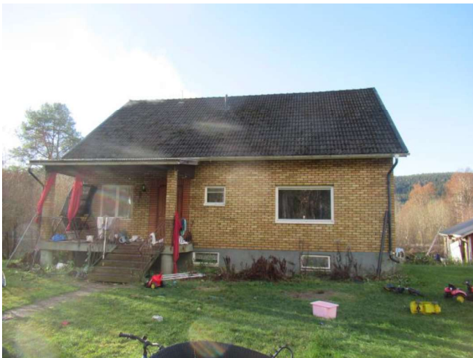
Foto, vy från framsida med gräsmatta samt inbyggd altan.
