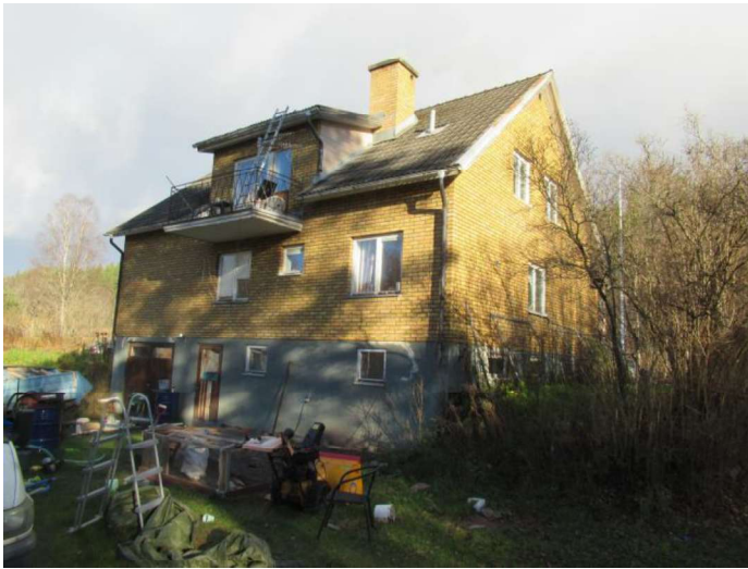
Foto, huvudbyggnad från baksida med suterräng och garageinfart.
