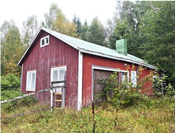
Foto, garage/förrådsbyggnad i rödmålad träpanel med vita detaljer.
