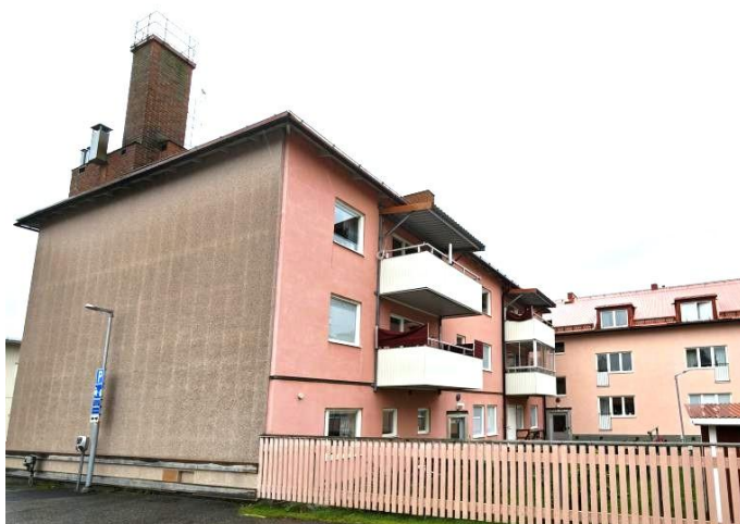
Foto, huvudbyggnad i 3 våningar, rosaputsad fasad, vita detaljer.
