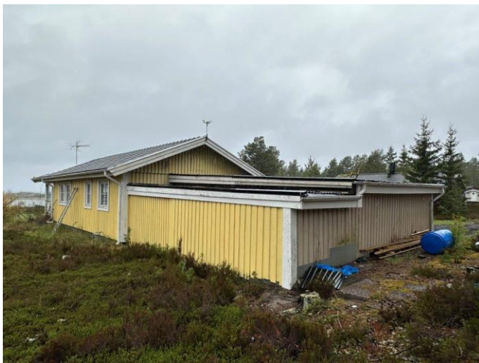
Foto, fasad mot baksidan med gul/beigemålad träpanel samt vita detaljer.
