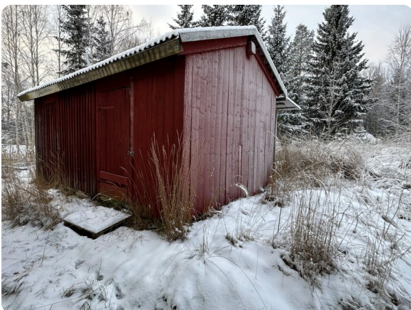
Foto förråd med röd panel
