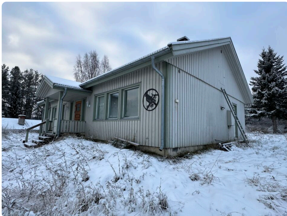
Foto entré- och gavelfasad av bostadshus med grågrön fasad
