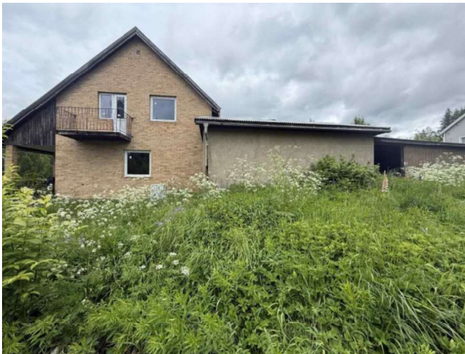
Foto, byggnadens baksida.
