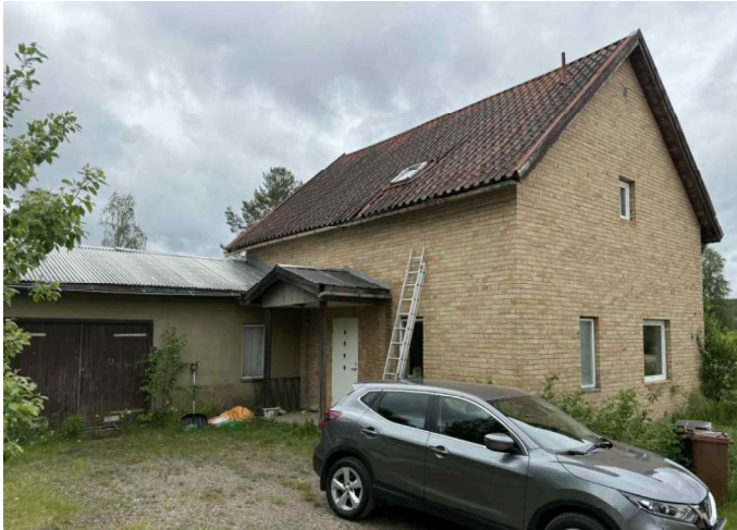
Foto, huvudbyggnadens entrésida. Garage byggd i vinkel.
