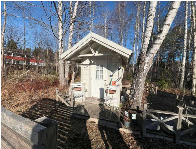
Foto, byggnad 2, friggebod, ljusmålad träfasad.
