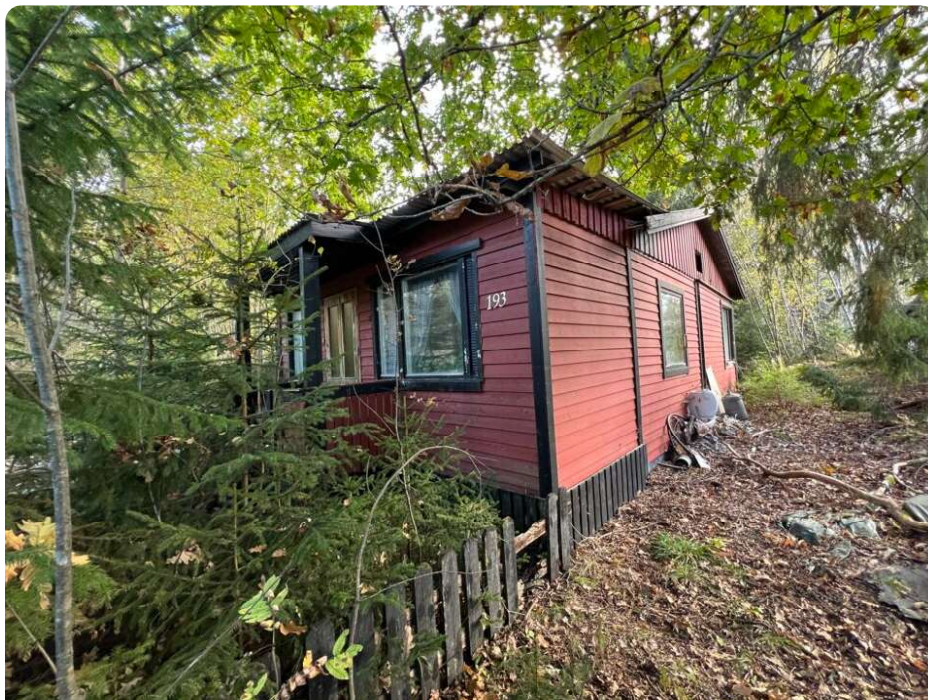
Byggnad med röd fasad och mörka detaljer samt vildvuxen tomt
