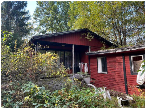
Byggnad med röd fasad och mörka detaljer samt vildvuxen tomt, vy från baksidan
