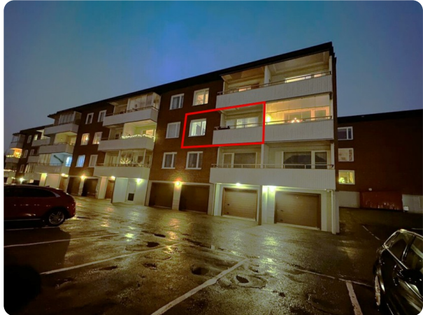
Foto fasad flerbostadshus i tegel med vita detaljer och balkonger. Markeringen visar läget för värderingsobjektet
