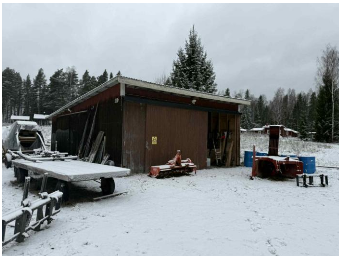
Foto, ekonomibyggnad maskinhall.
