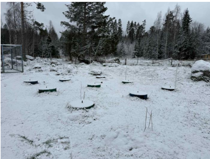
Foto, troligen påbörjad grundläggning.
