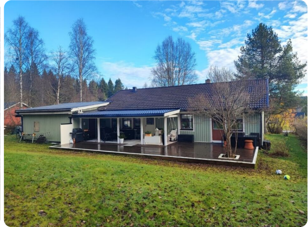
Foto, baksidan av huset med trätrall och skärmtak
