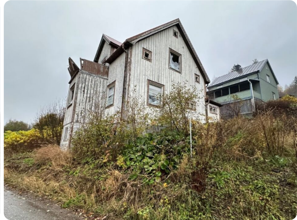
Huvudbyggnad med ljus fasad och bruna detaljer samt igenvuxen tomt
