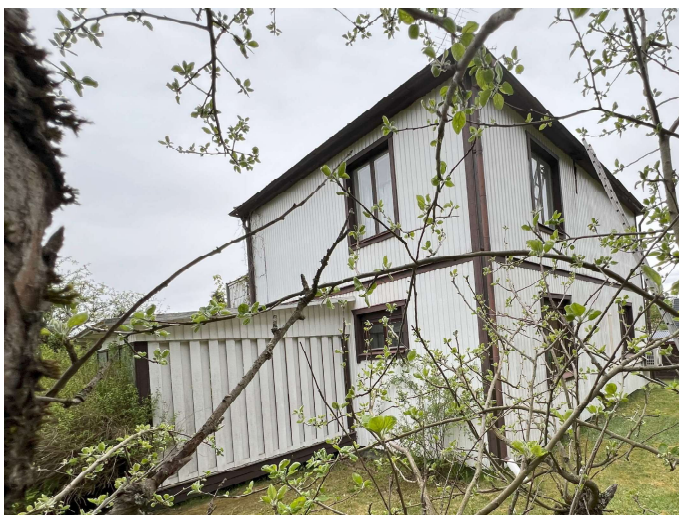
Foto, huvudbyggnad, fasadhörn mot sydöst, altan
