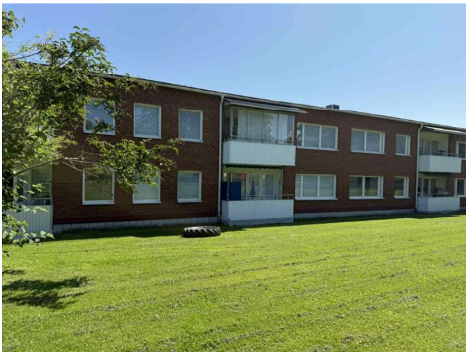
Foto, huvudbyggnadens baksida.
