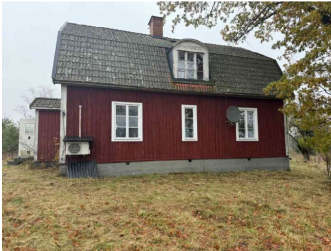
Foto, huvudbyggnadens baksida.
