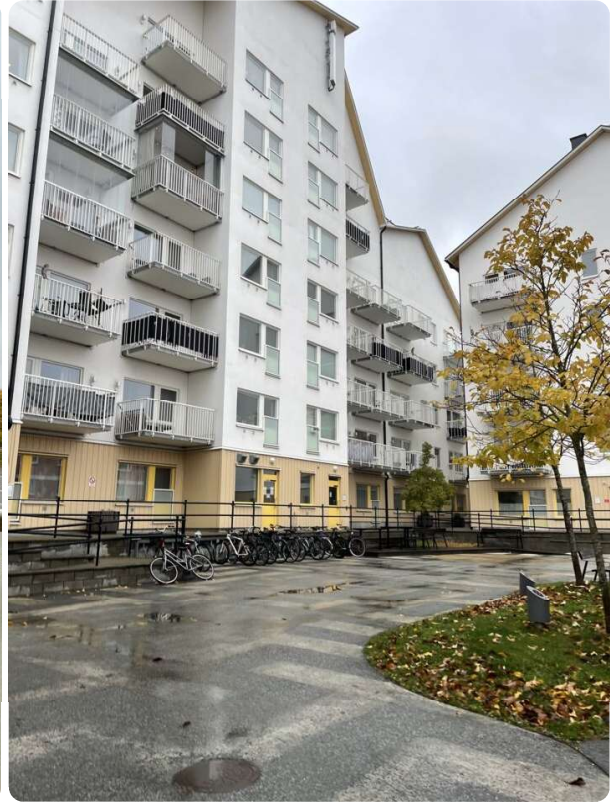
Innergård. Asfalterad med mindre gräsytor samt sittbänkar och cykelställ.
