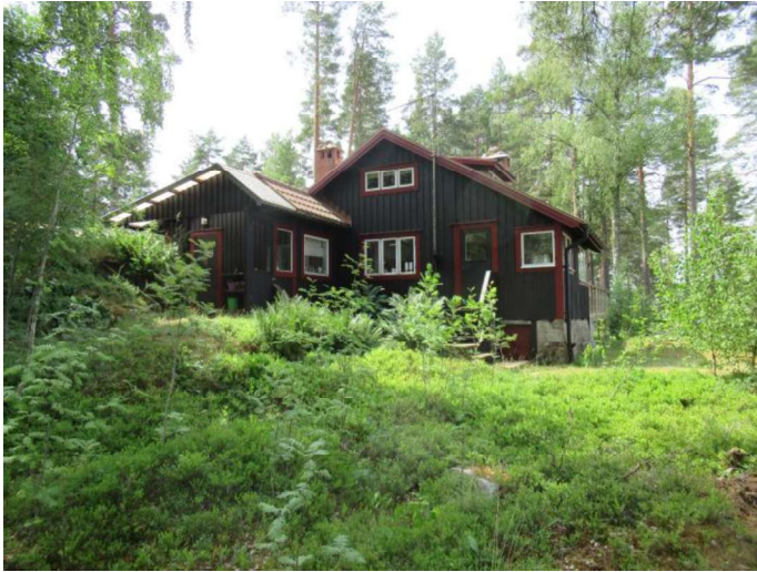
Foto, huvudbyggnad från sjösidan.
