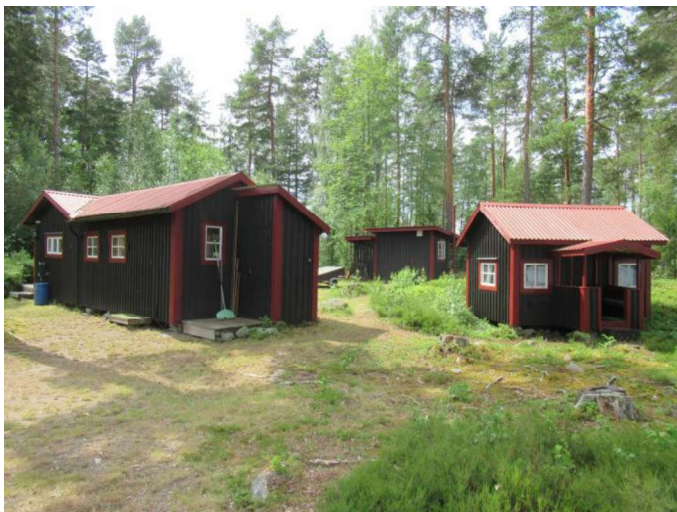
Foto, övriga byggnader, förråd och gästhus.
