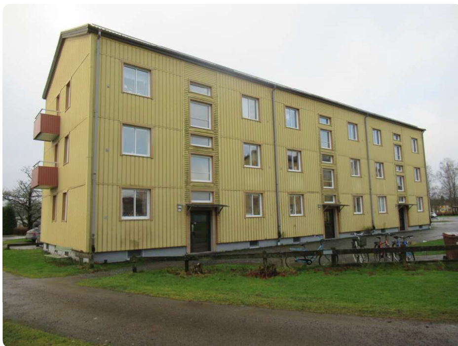
Huvudbyggnad med plåtfasad samt mindre grönytor
