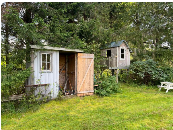
Förrådsbyggnad samt gräsmatta och träd
