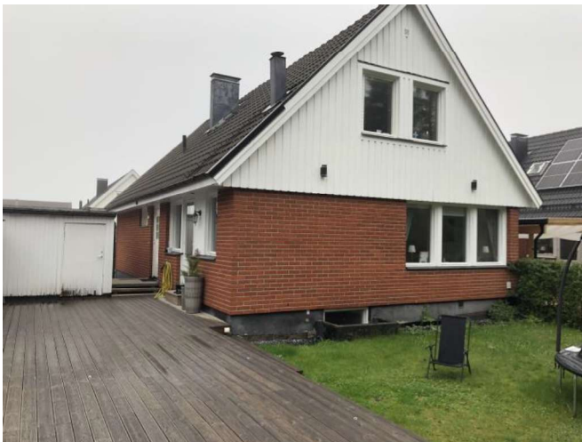
Foto, huvudbyggnad. Bostadshus av kedjehustyp med fasad av tegel samt vitmålad träpanel, vy från baksidan.
