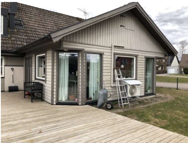
Foto, huvudbyggnad. Byggnad med ljus fasad och grå detaljer samt altandäck och gräsmatta.
