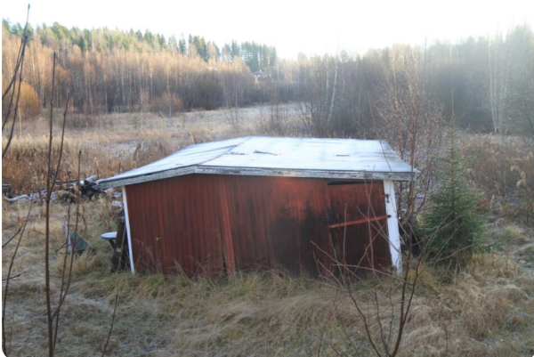
Foto garage/förråd, rödmålad träpanel och plåttak.
