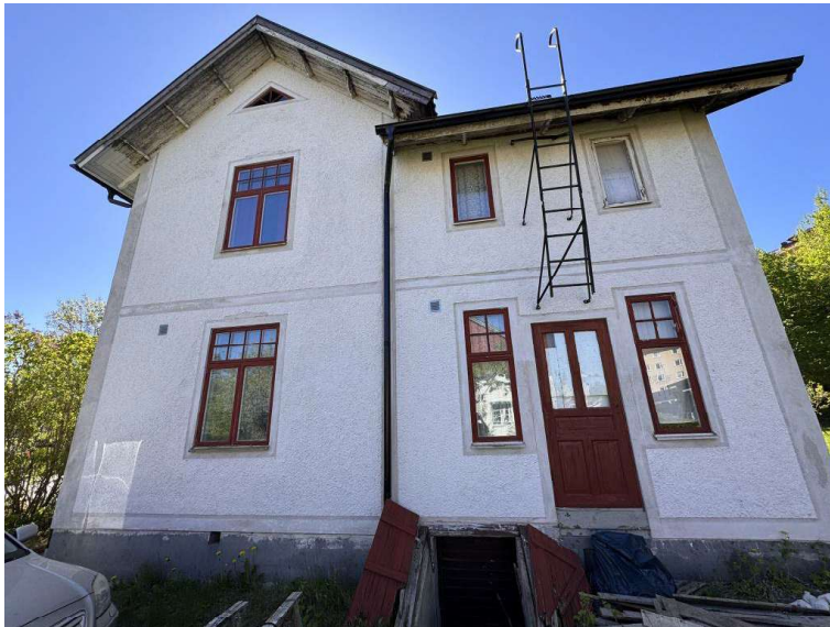
Foto, huvudbyggnad, vitputsad fasad med röda detaljer
