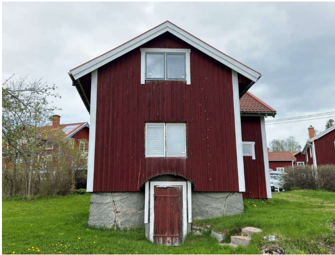
Foto. Huvudbyggnad. Sydgavel med matkällare.
