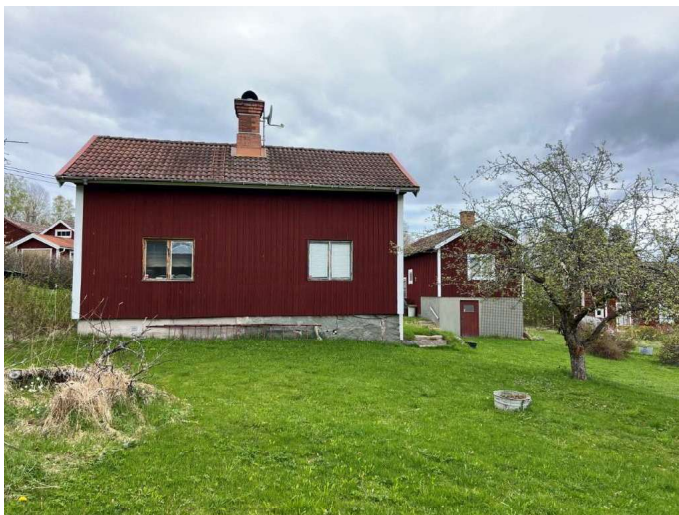
Foto. Huvudbyggnad. Längsida mot väst.
