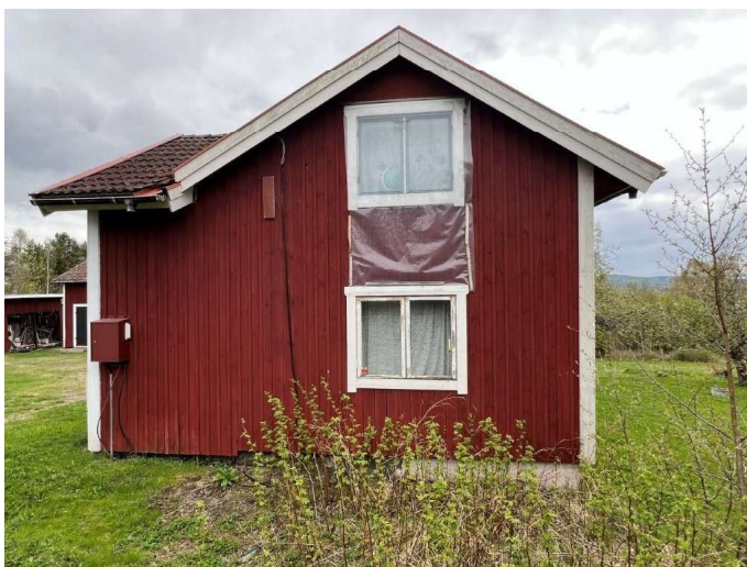
Foto. Huvudbyggnad. Kortsida mot norr.
