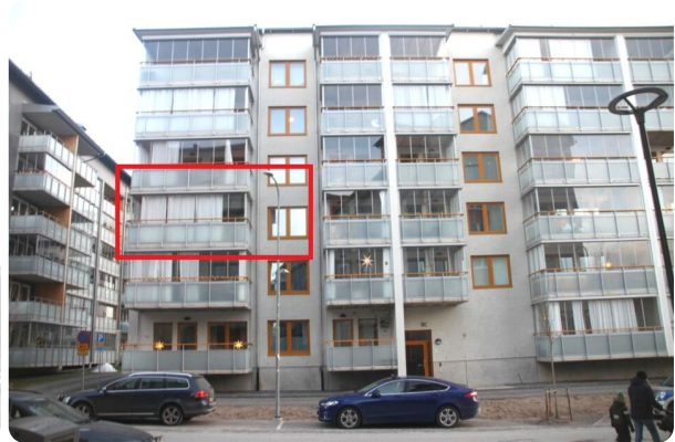
Foto huvudbyggnad, i sex våningar, ljus tegelpanel, inglasade balkonger.
