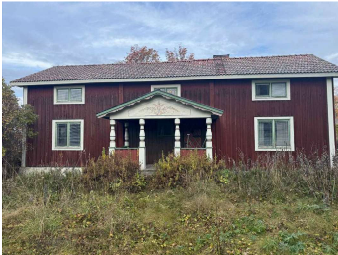
Foto, huvudbyggnaden entrésida.
