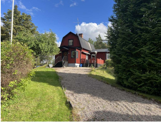
Foto, huvudbyggnad. Bostadshus med röd fasad och mörka detaljer samt trädgård med grusad yta, gräsmatta och träd.
