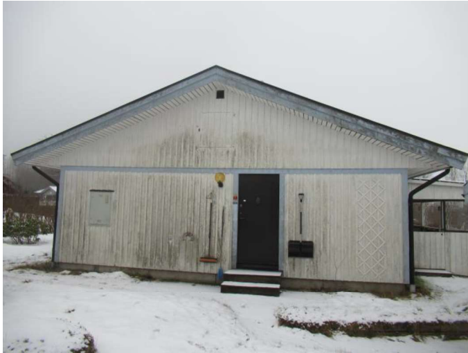
Foto, huvudbyggnad från sida med groventré.
