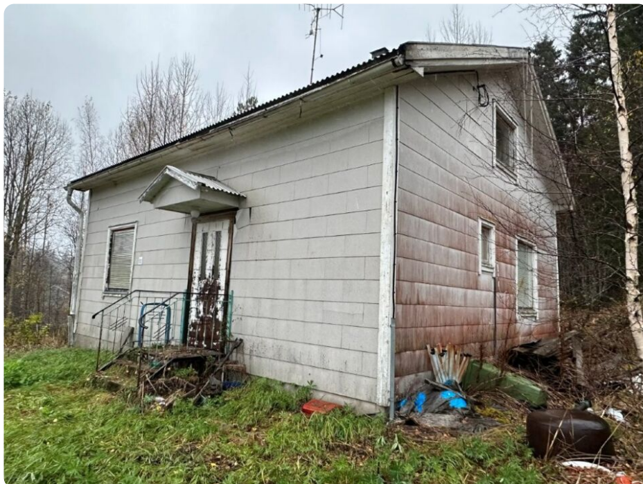
Entréfasad av huvudbyggnad med ljusa fasadplattor.
