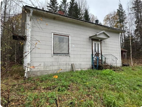
Entréfasad av huvudbyggnad med ljusa fasadplattor.
