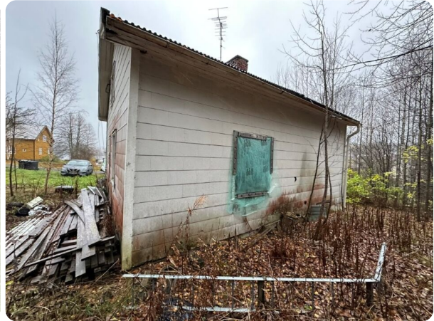
Fasad mot baksidan. Igensatt fönster.
