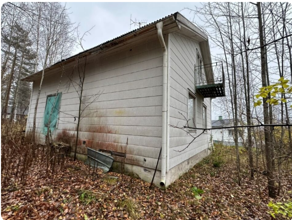
Fasad mot baksidan och gavel med äldre balkong.
