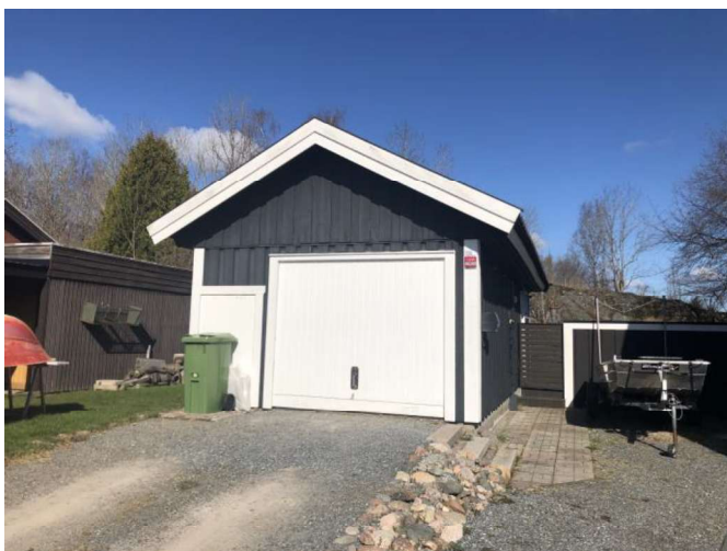
Foto, byggnad. Garagebyggnad med mörk träfasad med vita detaljer samt infart
