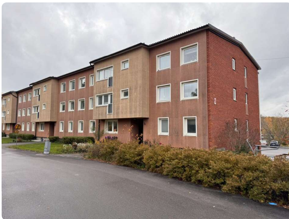
Huvudobjektet. Röd-brun fasad med ljusa detaljer
