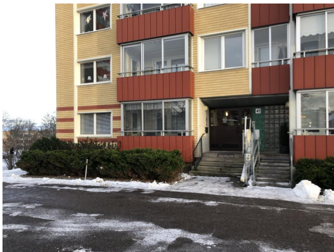
Foto, huvudbyggnad. Flerbostadshus med gul fasad och röda detaljer, värderingsobjektet markerat.
