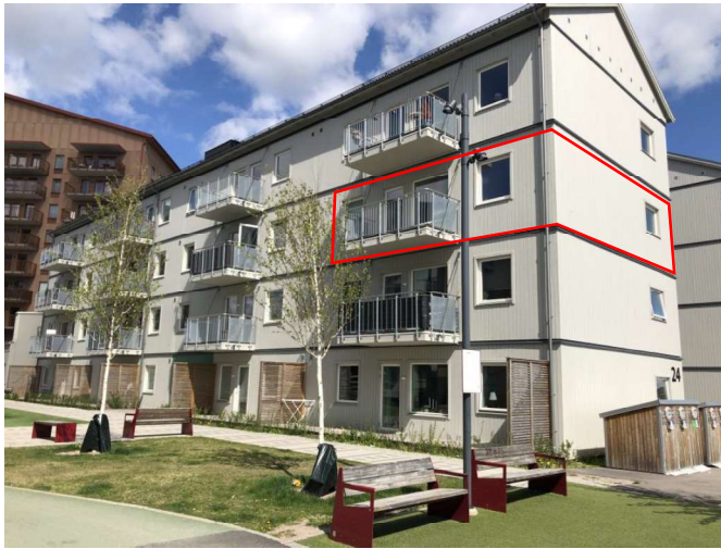
Foto, byggnad. Flerbostadshus i 4 plan med grå fasad, värderingsobjektet markerat.
