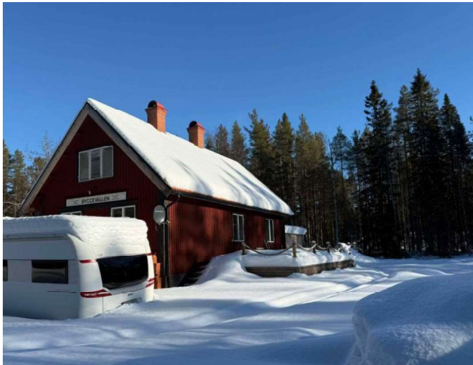
Foto, huvudbyggnadens baksida. Veranda och snötäckt mark ses i bild.
