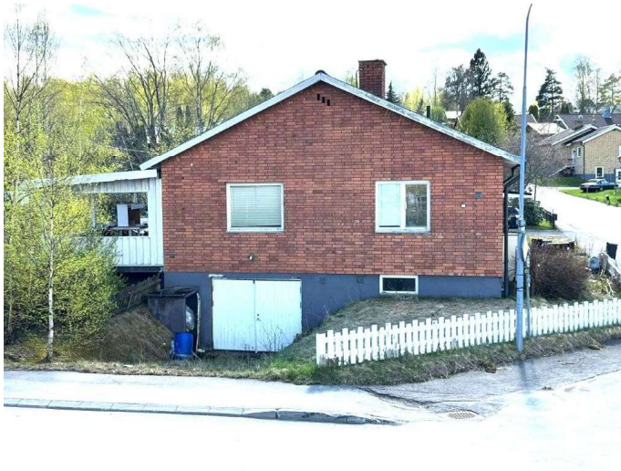
Foto, garage i källarplanet.
