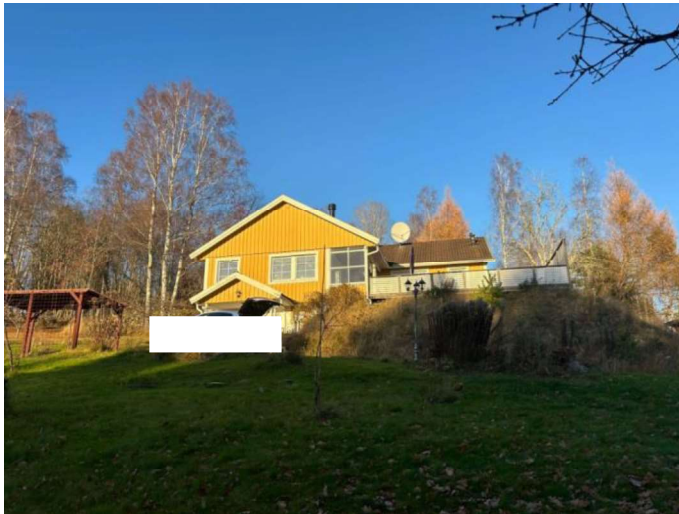
Foto, huvudbyggnadens framsida. Byggnaden är högt belägen på tomten.
