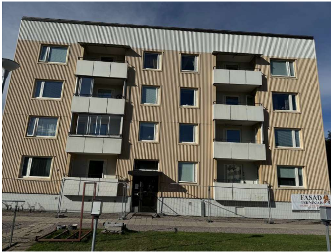
Foto, huvudbyggnad (Flerbostadshus i fyra våningar, med plåtfasad och balkonger)
