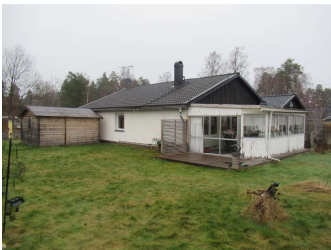
Foto, inglasad altan på byggnaden framsida.
