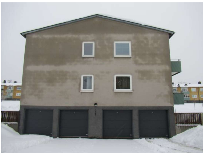
Foto, byggnaden från infart med garageplatser.
