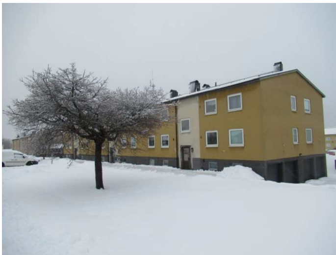
Foto, framsida med parkeringsplatser.
