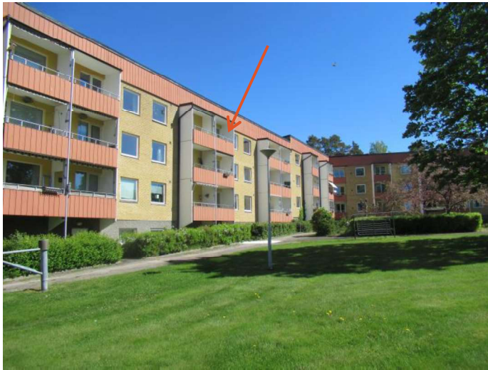
Foto, huvudbyggnad från baksida. Pilen visar läget på lägenheten.
