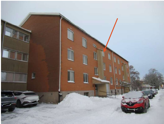
Foto, Byggnaden från entrésidan, pilen visar läget i byggnaden.
