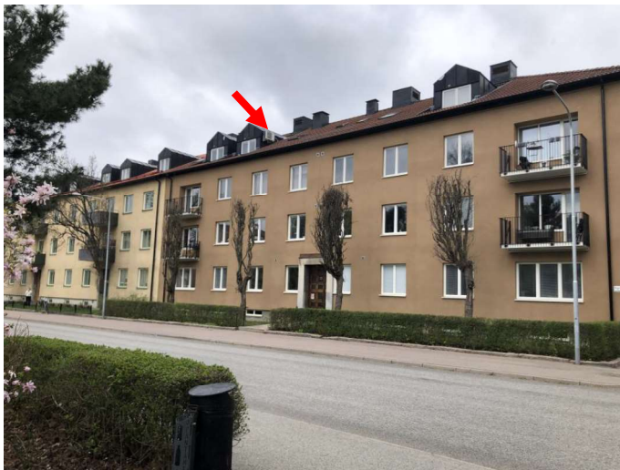
Foto, huvudbyggnad. Flerbostadshus med brun fasad och vita detaljer samt väg, värderingsobjektets läge markerat.
